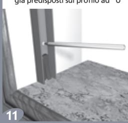
Spostare il profilo ad "U" forare ed inserire i tasselli (se l'installazione è su muro)
